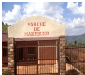
Marché de Makebuko avant la remise en état du réseau d'adduction d'eau
