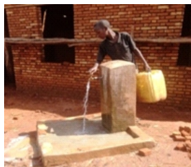
Borne fontaine fonctionnelle après la remise en état de l'adduction d'eau
